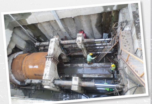
1560 metre atık su tünelinin 3 metre çapında olan çelik boruları, yatay itme yöntemiyle yerleştirildi. Kanalizasyon atıkları dereye karışmadan Moda'daki arıtma tesisine aktarılacak
